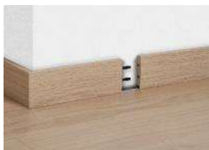
Verbinding van 2 plinten langs de muur
