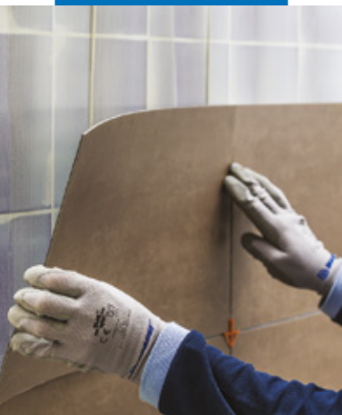
Plaatsing van LVT op een wand
