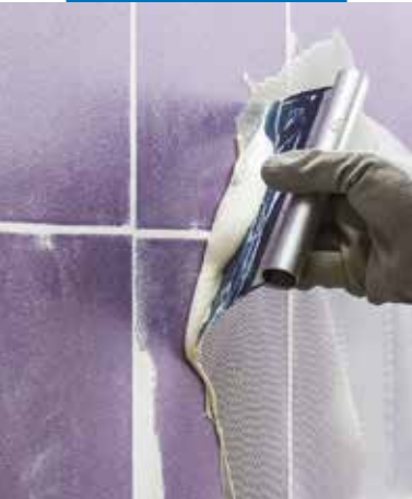
Verwerking van Ultrabond Eco MS 4 LVT Wall met een getande lijmkam op een niet-absorberende ondergrond
